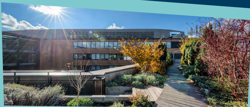
Budova Gamma – střešní terasa, vzrostlé stromy a keře, zadržování dešťových srážek
