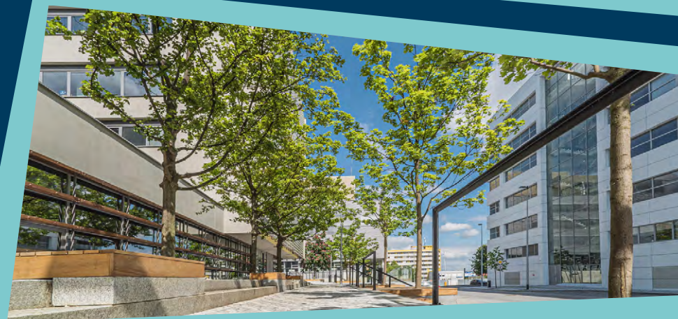
Želetavská ulice – dlážděné chodníky a komunikace umožňující zasakování, stromořadí, podzemní nádrže na dešťovou vodu
