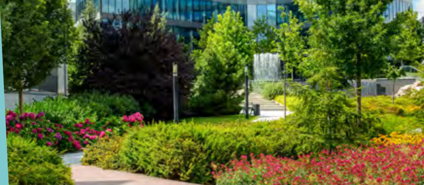
Budova Filadelfie – zeleň na podzemních železobetonových konstrukcích, veřejný park
